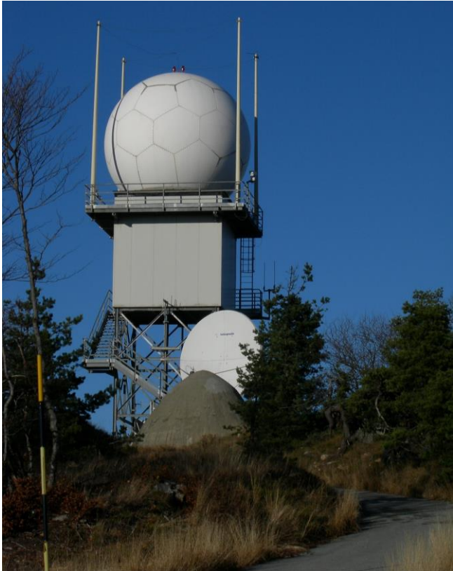
Radar di Monte Settepani (SV)
