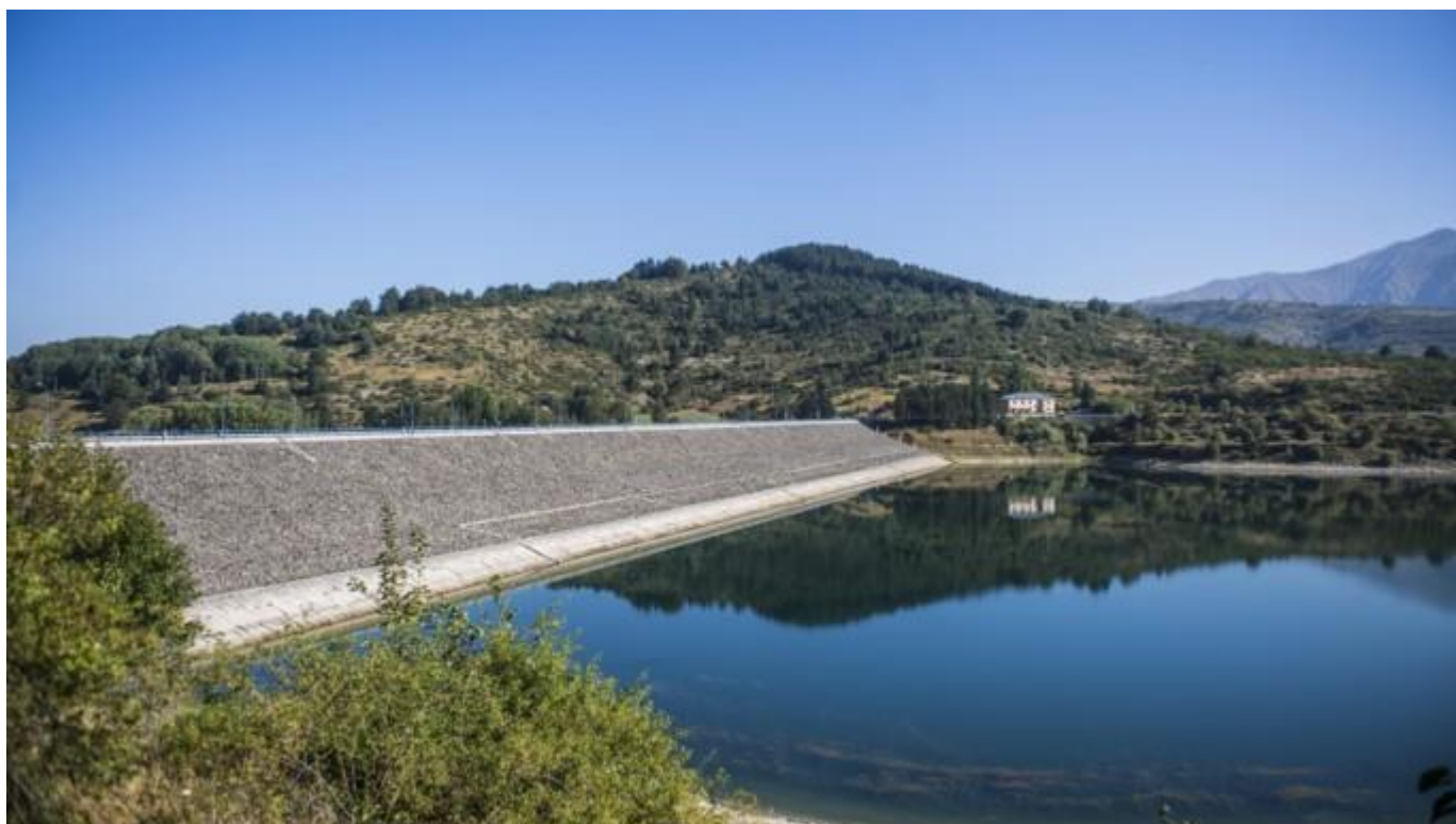
Diga di Poggio Cancelli – Campotosto (Aq).
