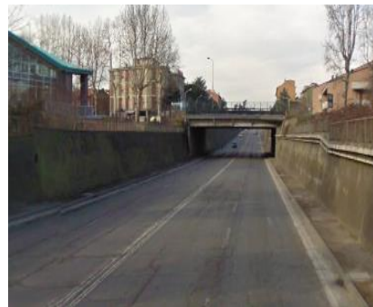
Ponti e viadotti attraversanti
