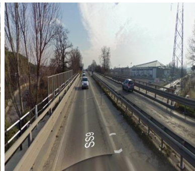
Ponti e viadotti
