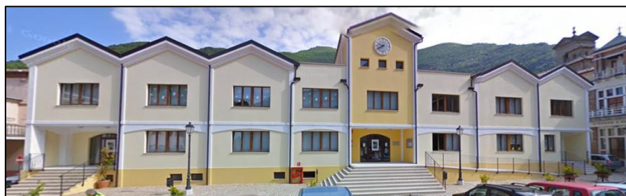
Figura 3 Vista frontale Scuola primaria e infanzia del comune di Pioraco prima dell'intervento
