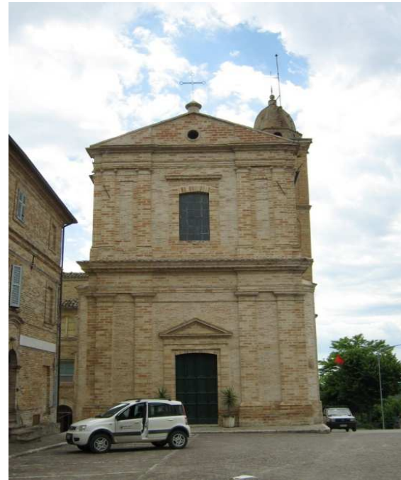
Foto 25 - Moregnano. I monumenti storici presenti nei centri minori presentano spesso caratteri costruttivi e formali di eccellente fattura, in nulla inferiori a quelli collocati nelle grandi città. L'impiego diffuso del cotto e della pietra non è mai legato a soluzioni banali e ripetitive. Anche le costruzioni in apparenza più semplici mostrano una notevole accuratezza nelle opere di finitura. (Foto Raffaella Diletti)
