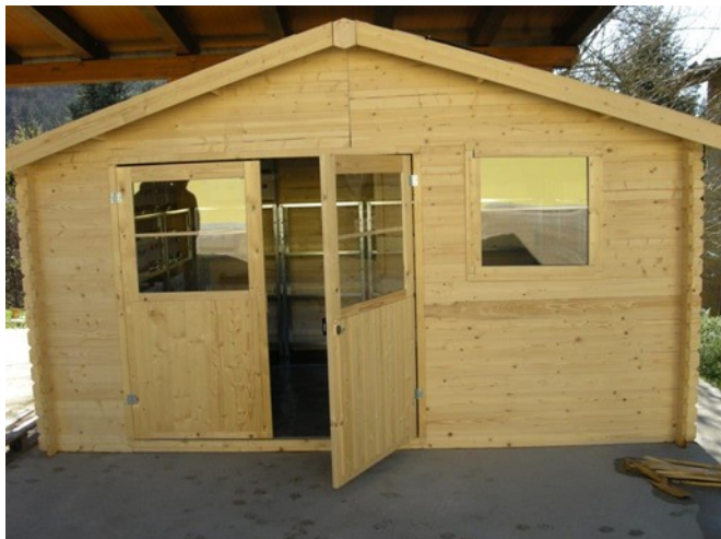
Foto 3 Struttura per stoccaggio galle
