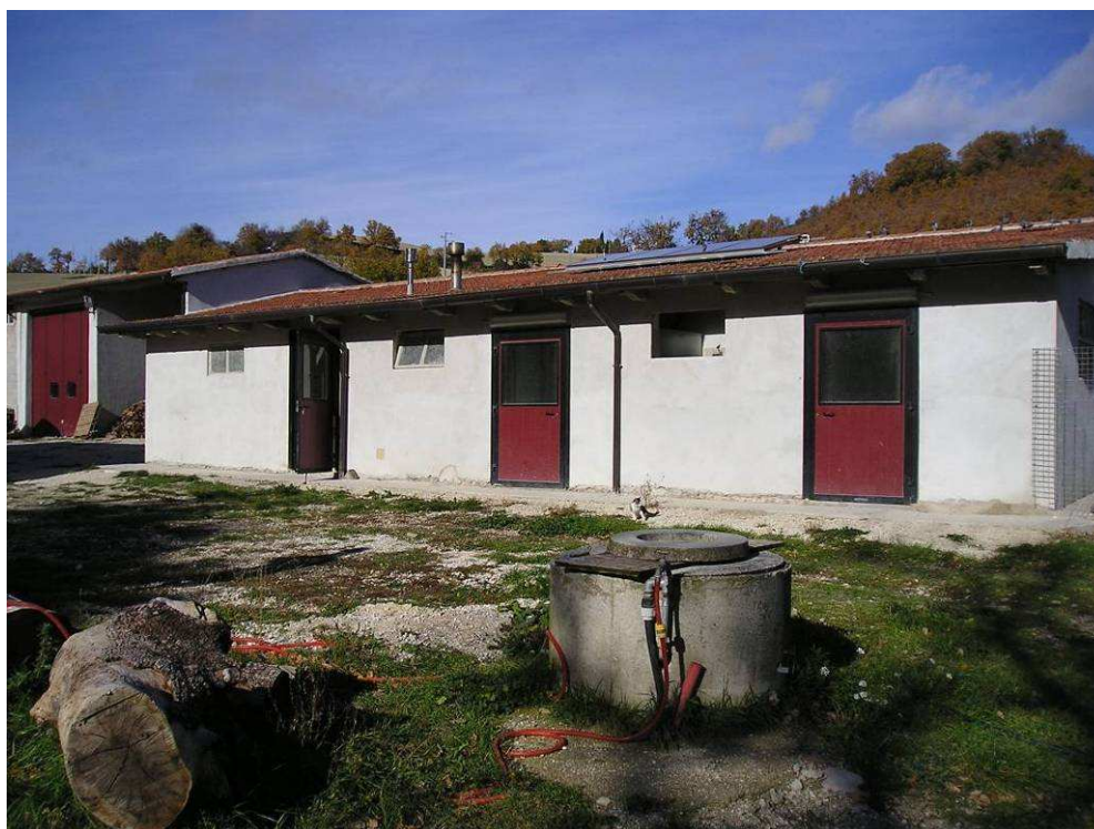
Laboratori e locale centrale termica
