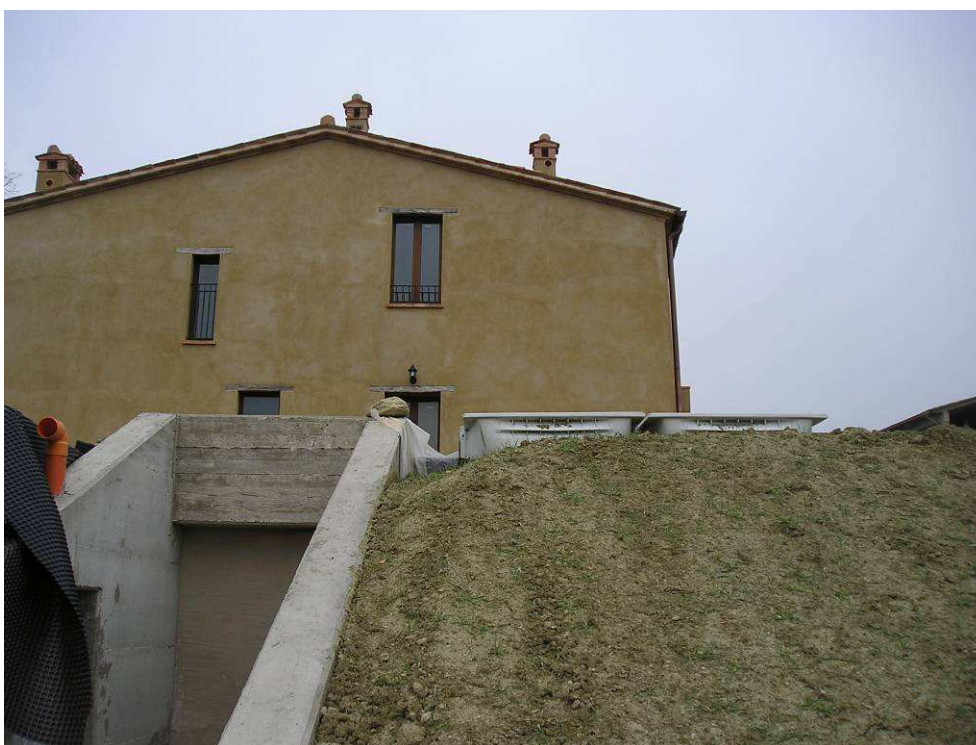
Ingresso locale caldaia
